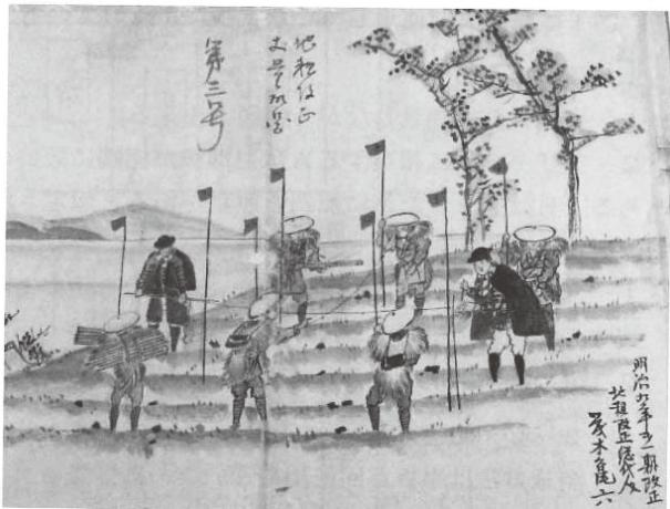
図7は、十字法による求積の風景である。
